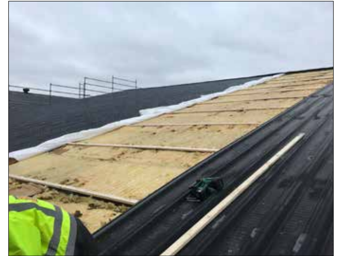
Byte av plåttaket tennishall bana 3, 4, 5.
