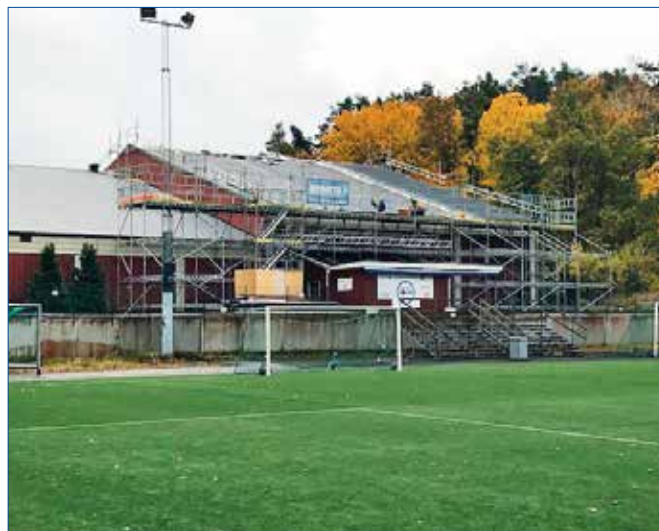
Byte av badmintonhallens tak i höstas (Anläggning).
