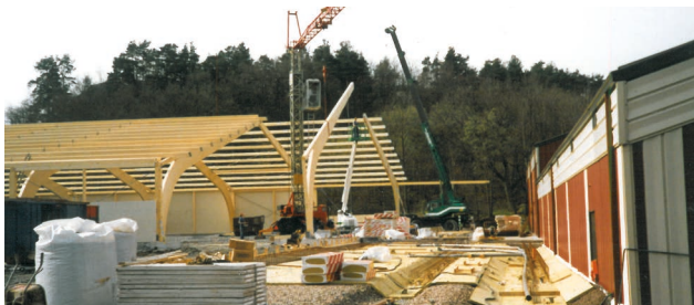
Hallen för tennisens bana 3, 4, 5 byggs (1989)
